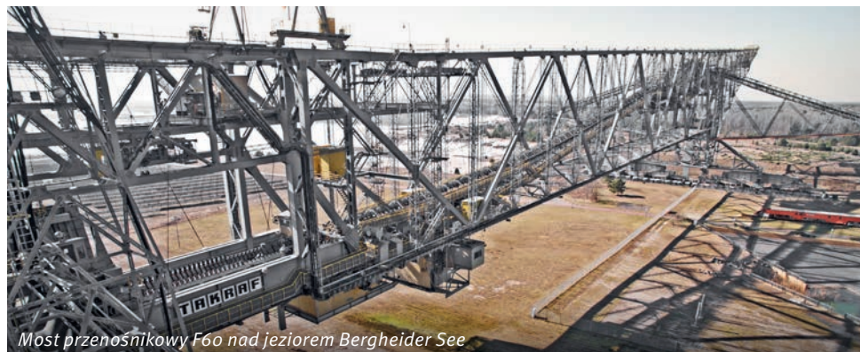
Most przenośnikowy F60 nad jeziorem Berghelder See
